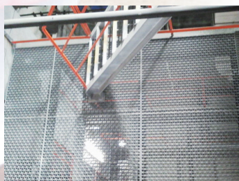
46.プラント施設
