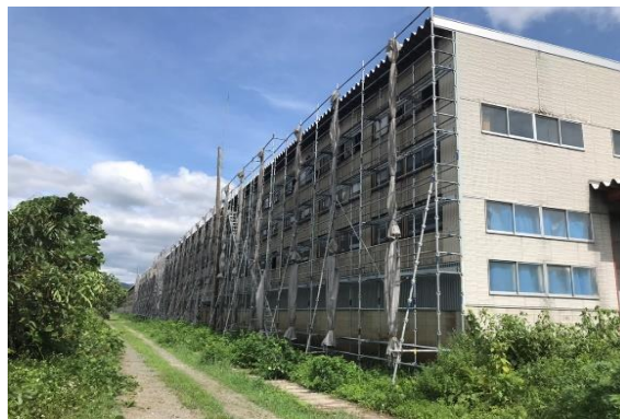
マキテック様米沢工場 施工写真
