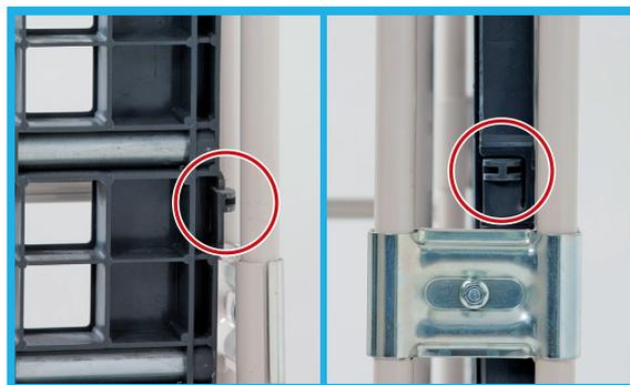
底板を解除し、背面側に跳ね上げ、底板左右のフックが左・右面側パネルと背面側パネルの間に入るようセットします。
